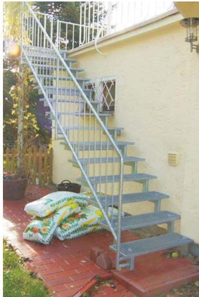
Geradläufige Treppe Mit 5 Steigungen, Austrittspodest, Podestgeländer und Podeststütze
